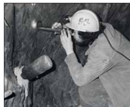
Měření porušenosti horniny pomocí introskopu, Uhelny doly Příbram, na snímku J. Přidal, zaměstnanec Uhelnych dolů Příbram, bez datace, foto Renáta Louvarová (Záběhlická) ÚSMH AV ČR, sbírka fotografií
