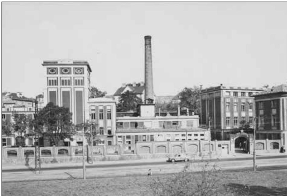
Pohled na areál Hornického ústavu v roce 1966, foto J. Plechatý A AV ČR, fond Reportáže ČSAV a AV ČR, sign. FOP 844, č. 10
