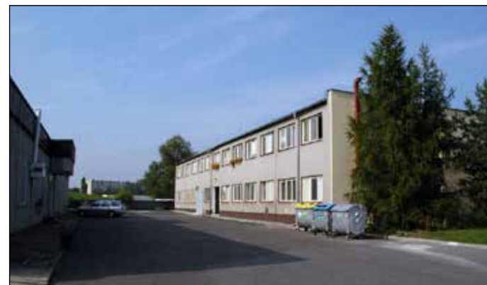
Bývalé budovy Geologického ústavu ČSAV před zbouráním, rok 2007 Geologický ústav AV ČR, v. v. i., osobní archiv prof. P. Bosáka
