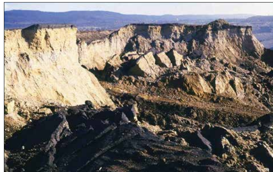
Hlubokým sesuváním postižený skrývkový řez hnědouhelného velkolomu Čs. armády, v pozadí krušnohorský zlomový svah ÚSMH AV ČR
