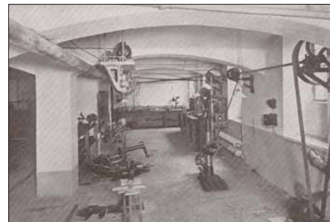
Prostory Ústavu pro vědecký výzkum uhlí - mechanická dílna In: Ústav pro vědecký výzkum uhlí v Praze, 1930
