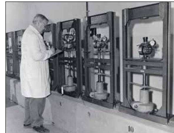
Reologické (dlouhodobé) zkoušky hornin v prostém tlaku na mechanických (pružinových) lisech, doc. Houska, bez datace, foto Renáta Louvarová (Záběhlická) ÚSMH AV ČR, sbírka fotografií
