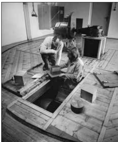
Odstředivka v laboratoři fotoelasticimetrie, dr. Kolář, bez datace, foto: autor neuveden ÚSMH AV ČR, sbírka fotografií
